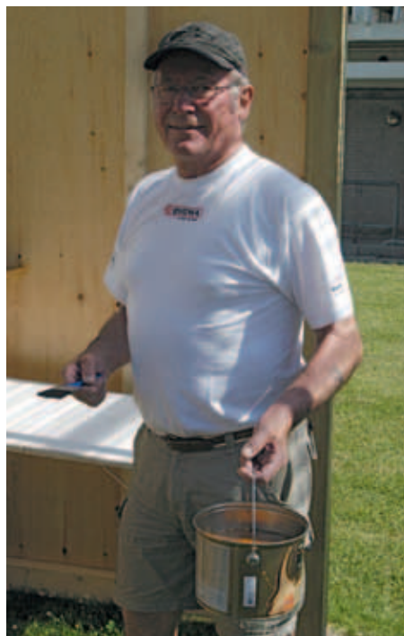
Hansen kigger stadig forbi, her lægger han sidste hånd på den nye pølsebod ved Hornbæk Hallen.
